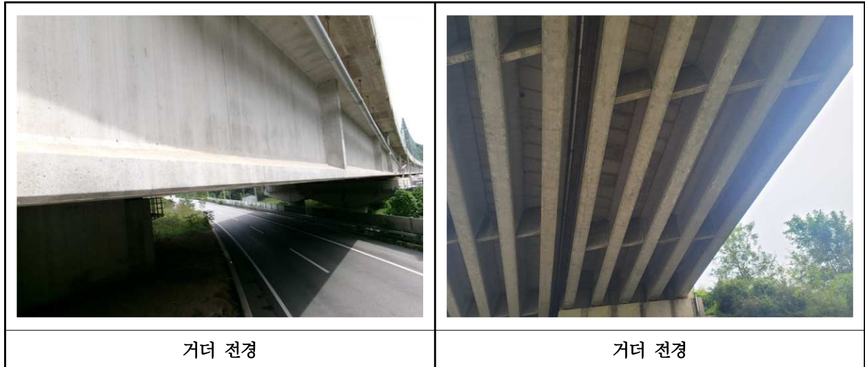
【사진 2.3.29】 거더 전경
