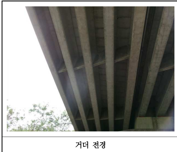
【사진 2.3.4】 거더 전경
