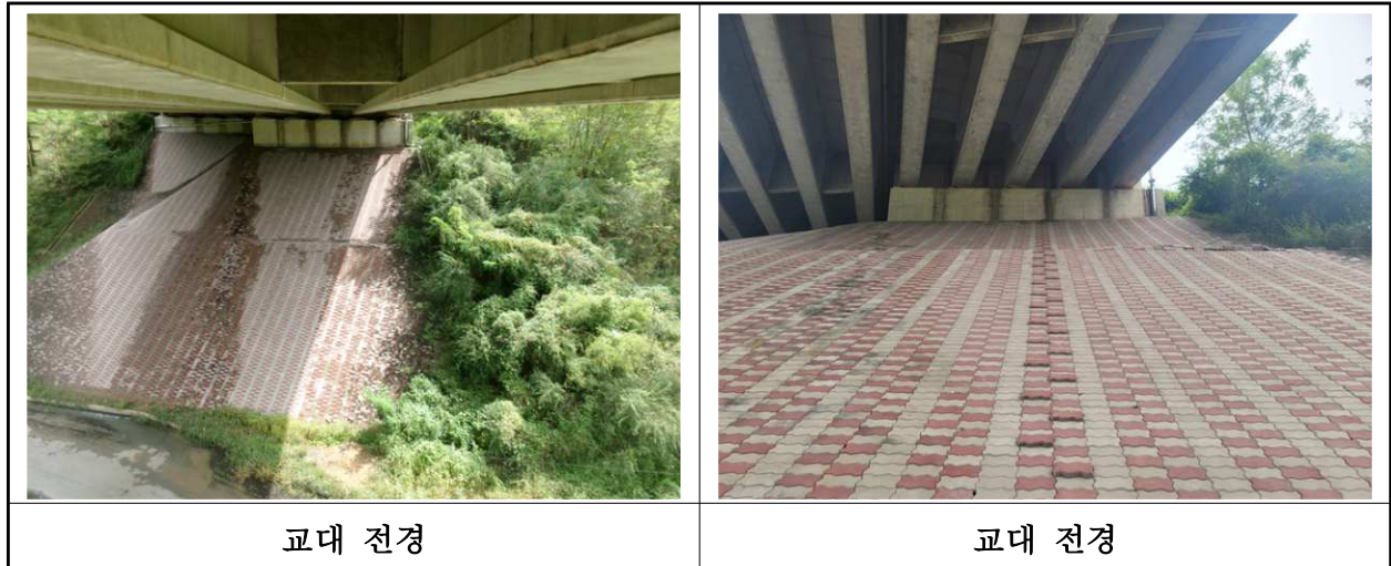
【사진 2.3.33】 교대 전경
