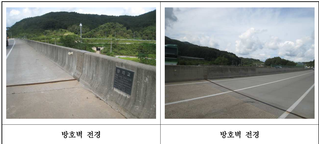
【사진 2.3.23】 방호벽 및 중앙분리대 전경
