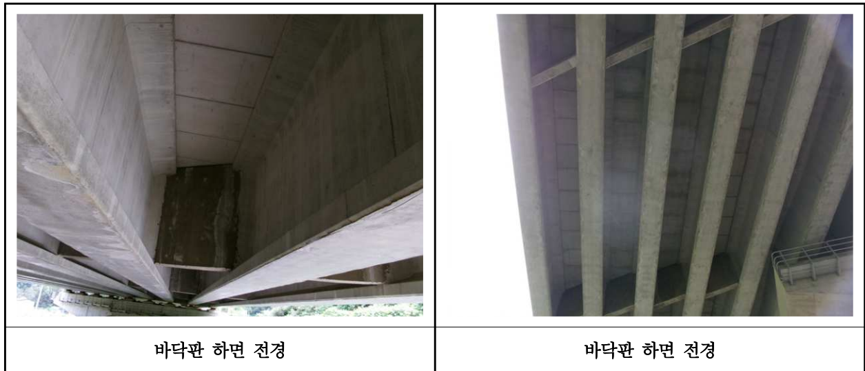
【사진 2.3.27】 바닥판하면 전경
