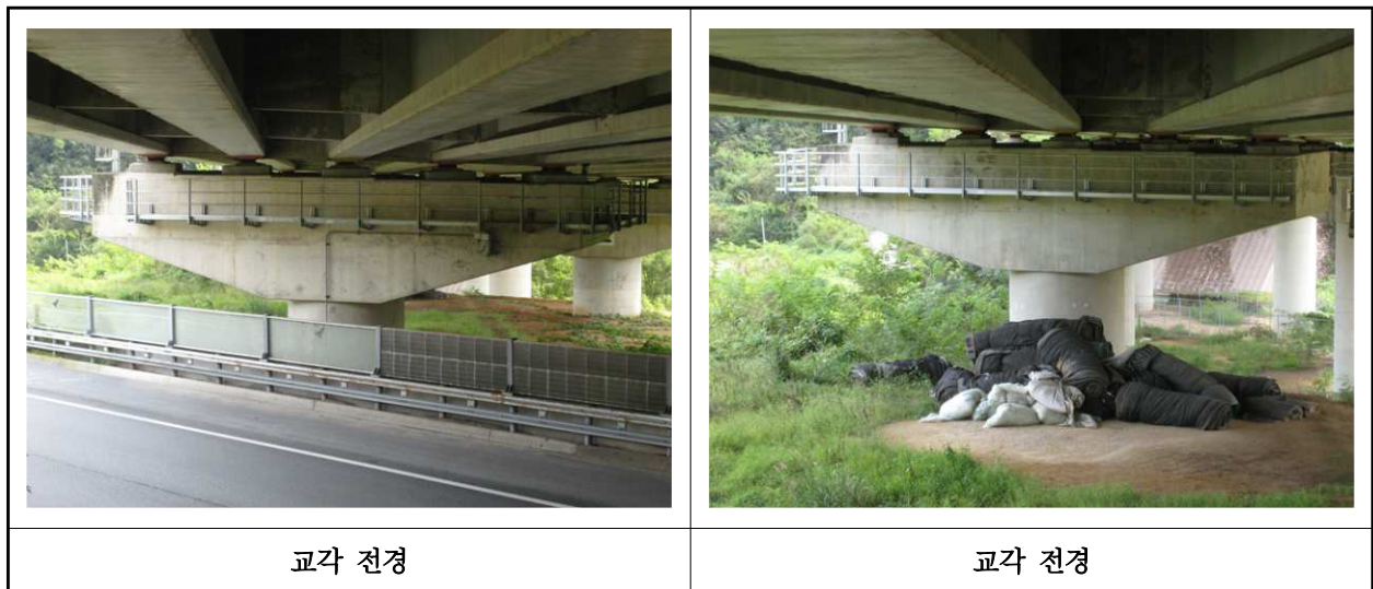
【사진 2.3.10】 교각 전경
