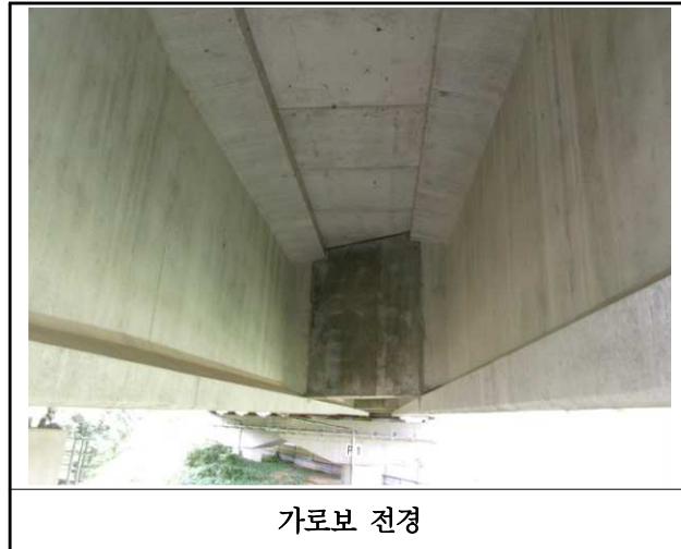
【사진 2.3.6】 가로보 전경
