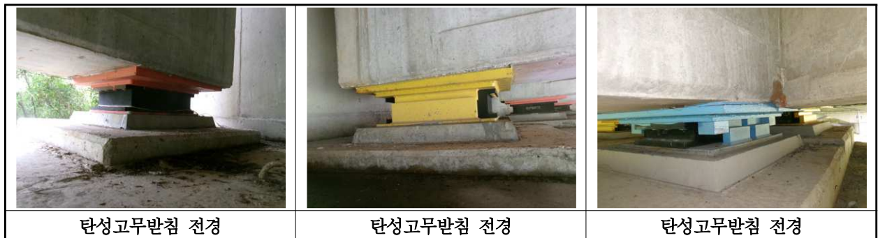
【사진 2.3.12】 교량받침 전경
