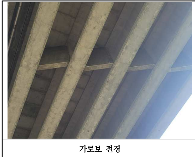
【사진 2.3.31】 가로보 전경
