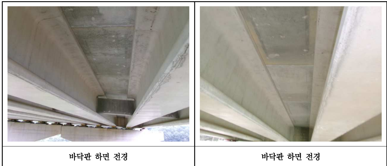
【사진 2.3.2】 바닥판하면 전경
